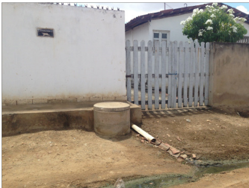
Figura 84 - Foto ilustrando esgoto a céu aberto em Mogeiro-PB
