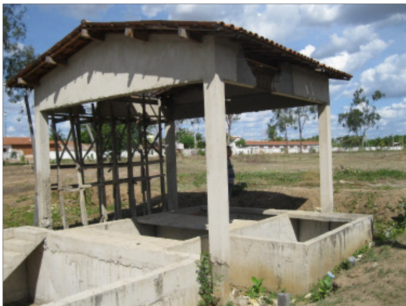
Figura 87 - Foto referente às obras da estação elevatória em Icó-CE
