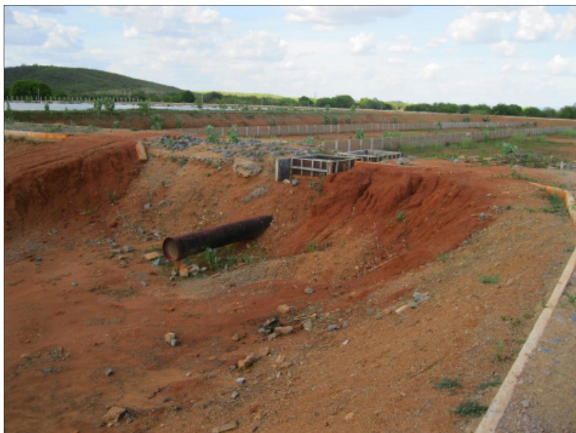
Figura 88 - Foto referente às obras da ETE em Icó-CE
