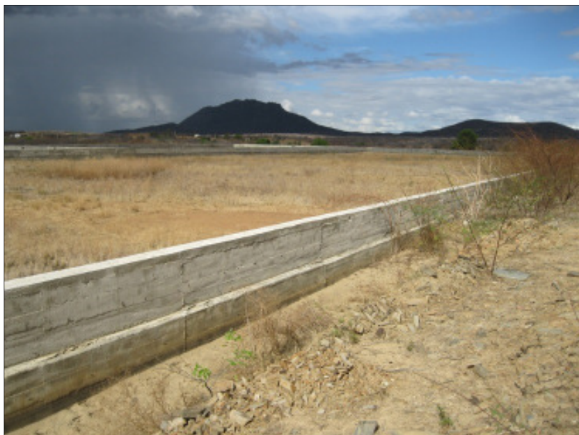
Figura 85 - Foto referente às obras de esgotamento sanitário em Jurucutu-RN
