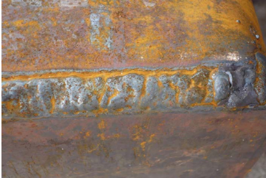
Figura 33 – Mordeduras no cordão de solda
