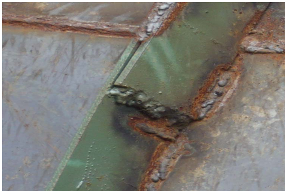
Figura 42 – Porosidade em junta soldada
