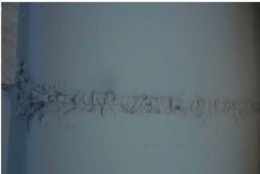
Figura 26 – Falta de penetração em parte do cordão de solda
