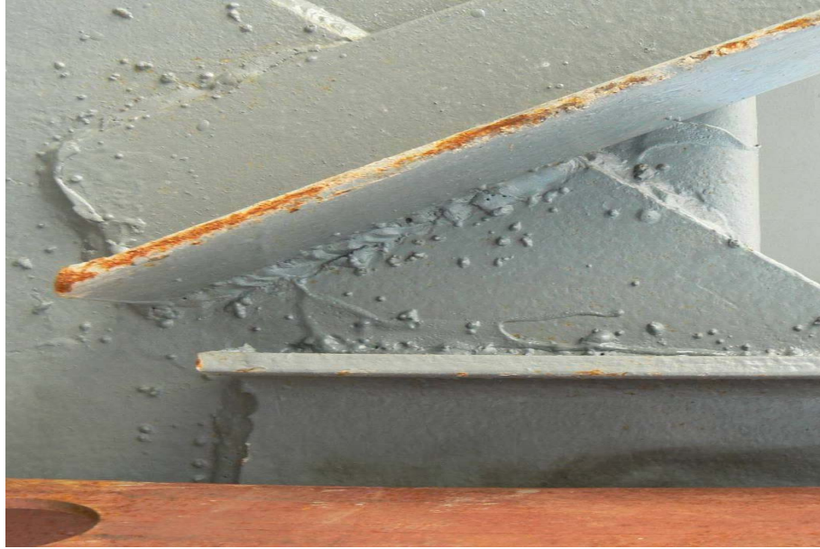
Figura 31 – Respingo excessivo
