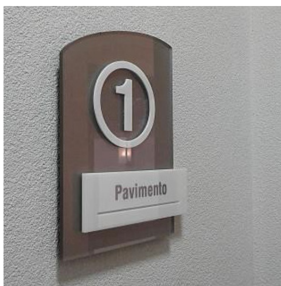
Figura 2: Sinalização de alto relevo, informando o número do pavimento.
