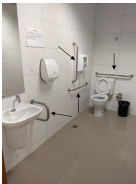
Figura 24: banheiro acessível com parede lateral, com as barras.
