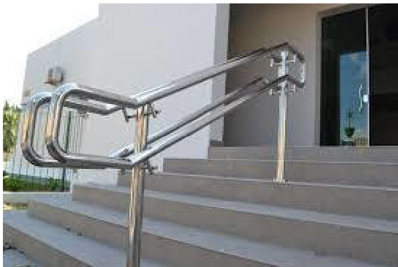
Figura 9: Corrimão acessível contínuo no centro da escada.
