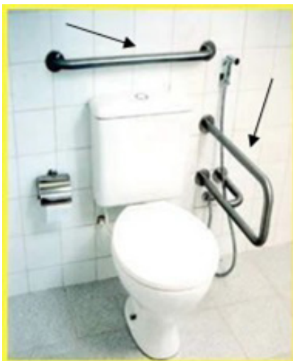
Figura 27: vista frontal do banheiro acessível sem parede lateral.
