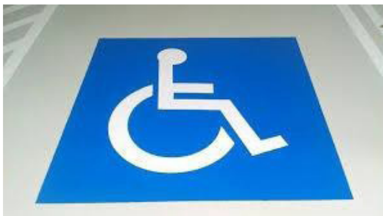
Figura 48: Sinalização horizontal para vaga de deficientes.
